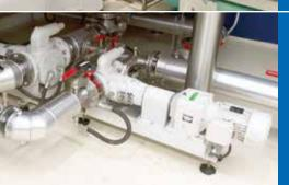
NORD-Stirnradgetriebemotor treibt Pumpen an.
